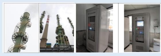
图 6.1-6 现有监测平台、在线监测仪
