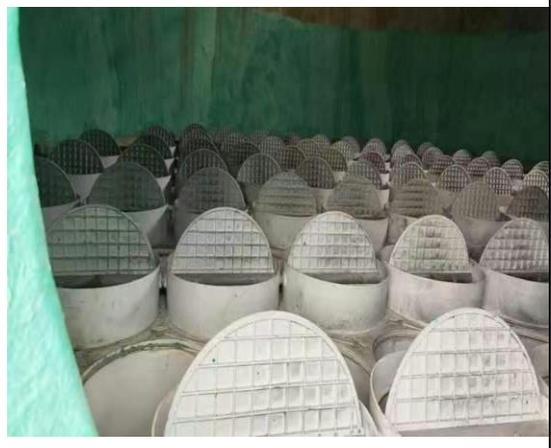
脱硫工段除雾器（二级圆柱旋风式除雾器）
