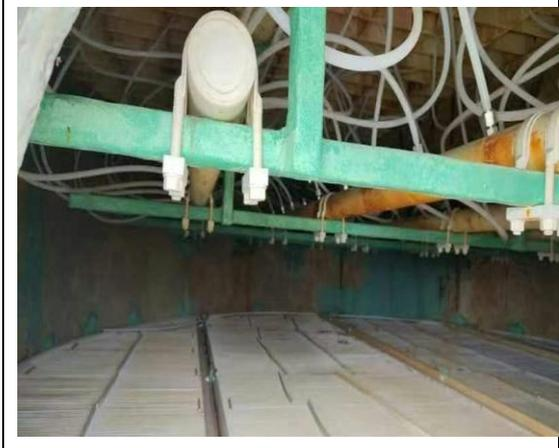
脱硫工段除雾器（一级平板波纹式除雾器）
