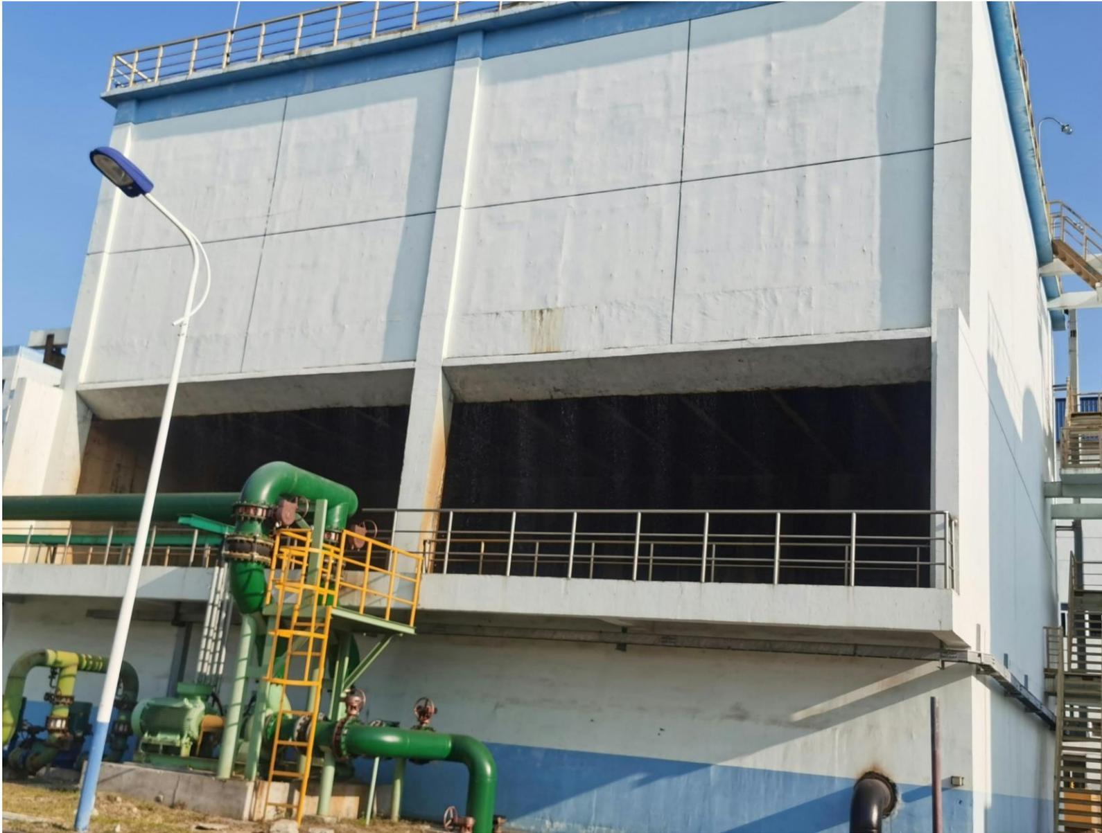
图 3.1-5 干法制酸装置循环水系统（实际建设）
