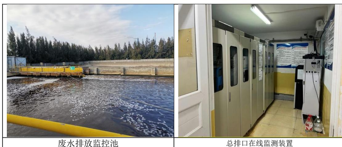
图 4.3-1 废水规范化排污口及在线监测装置
